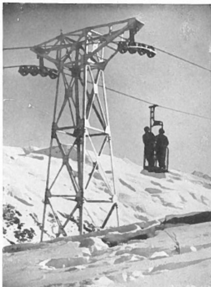
Le télébenne. - Passage d'un pylône
